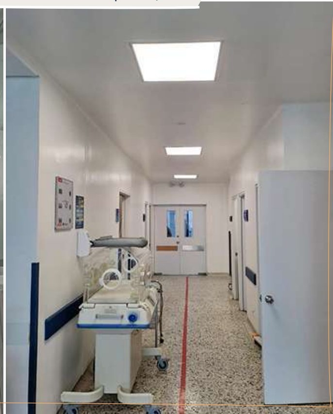
Proceso de sustitución de iluminación convencional por LED, fase II.
